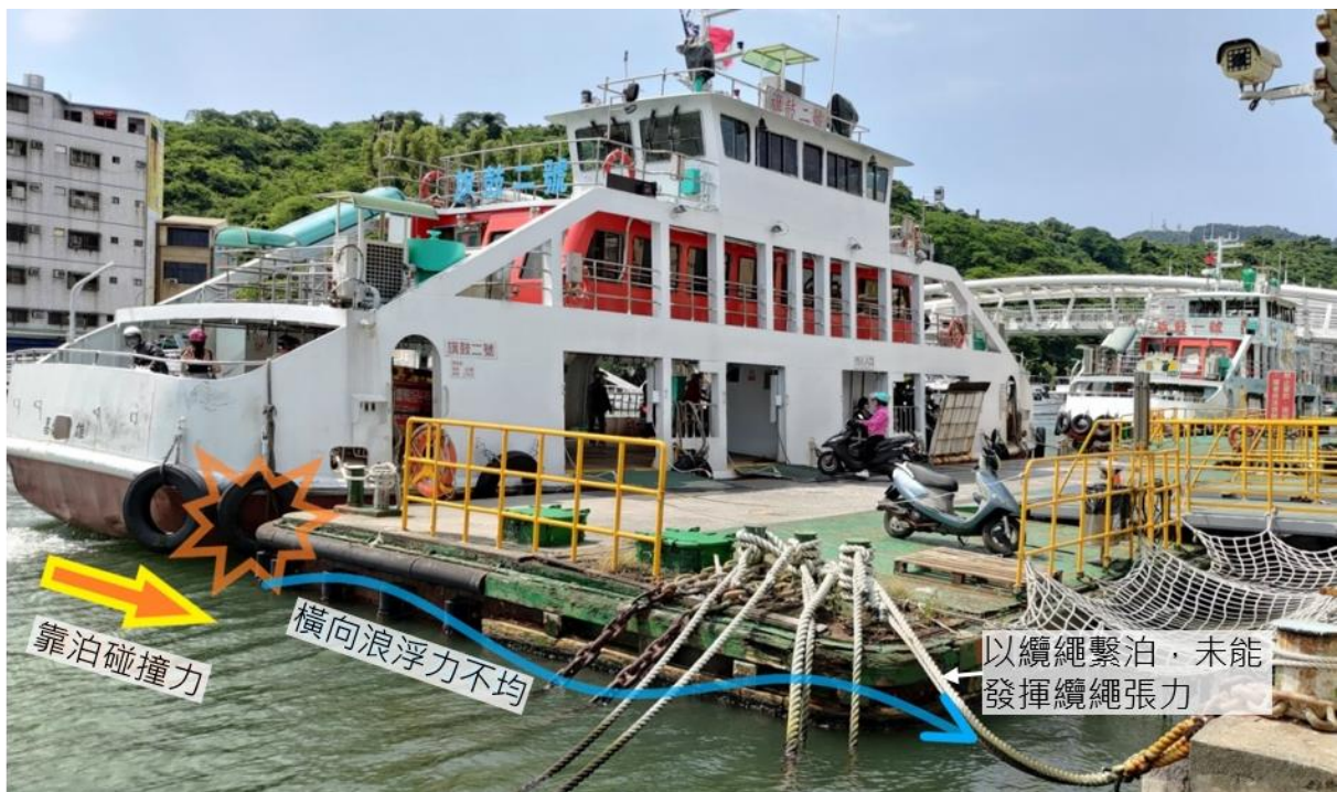
圖 4-3-7 鼓山渡輪靠泊浮動碼頭纜繩無法發揮張力示意照片
