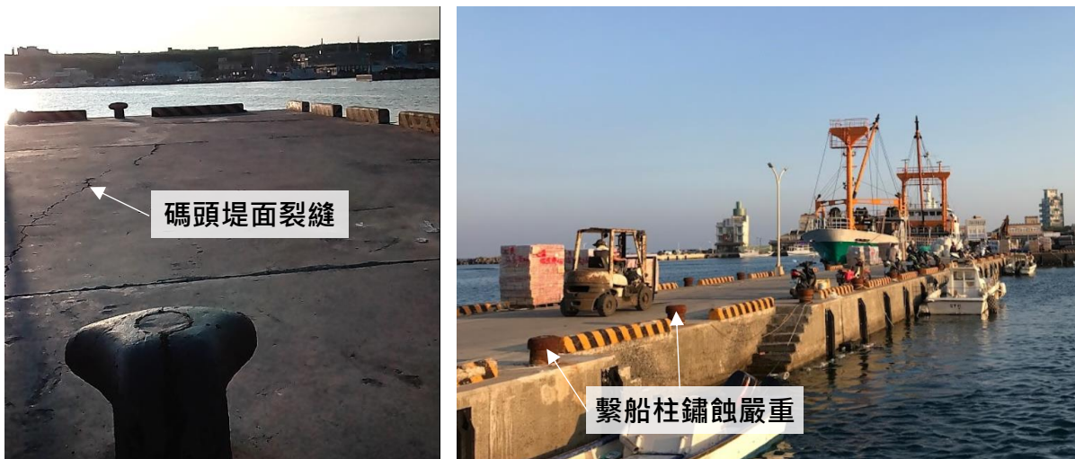
圖 4-4-13 七美南滬港貨運碼頭現況照片
