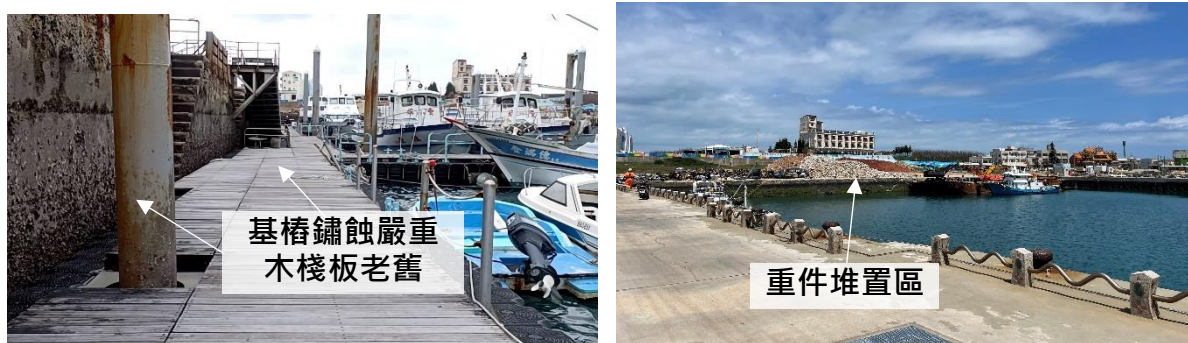
圖 4-4-18 吉貝港觀光遊憩船(載客小船)浮動碼頭及重件堆置區現況照片
