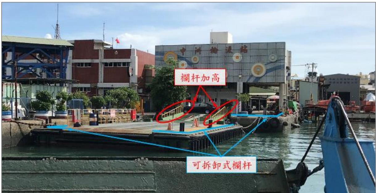
圖 4-3-8 躉船式浮動碼頭、棧橋及碼頭現況照片及設置安全設施示意圖
