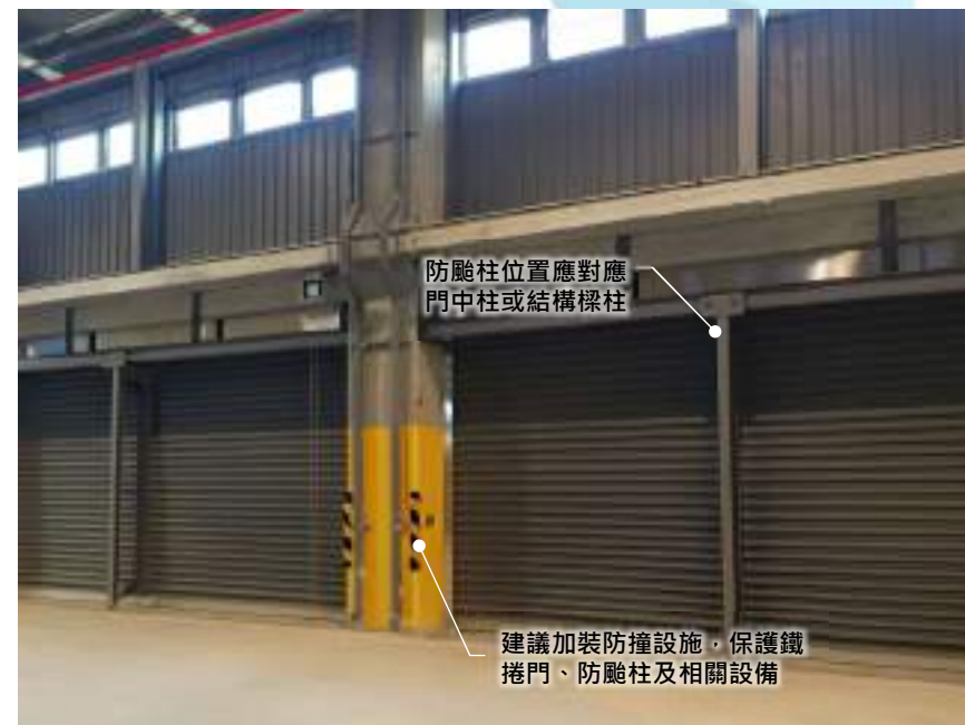
圖G-02-3 鐵捲門防颱柱示意圖
