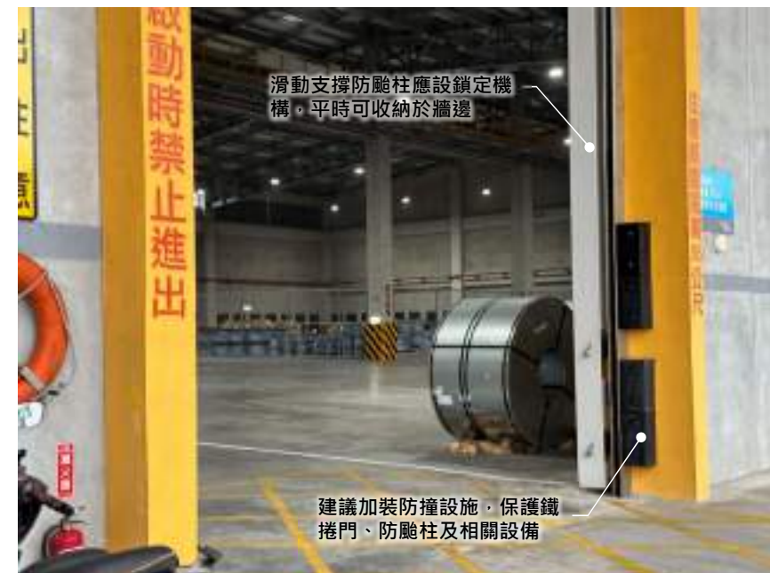
圖G-02-4 鐵捲門防颱柱示意圖
