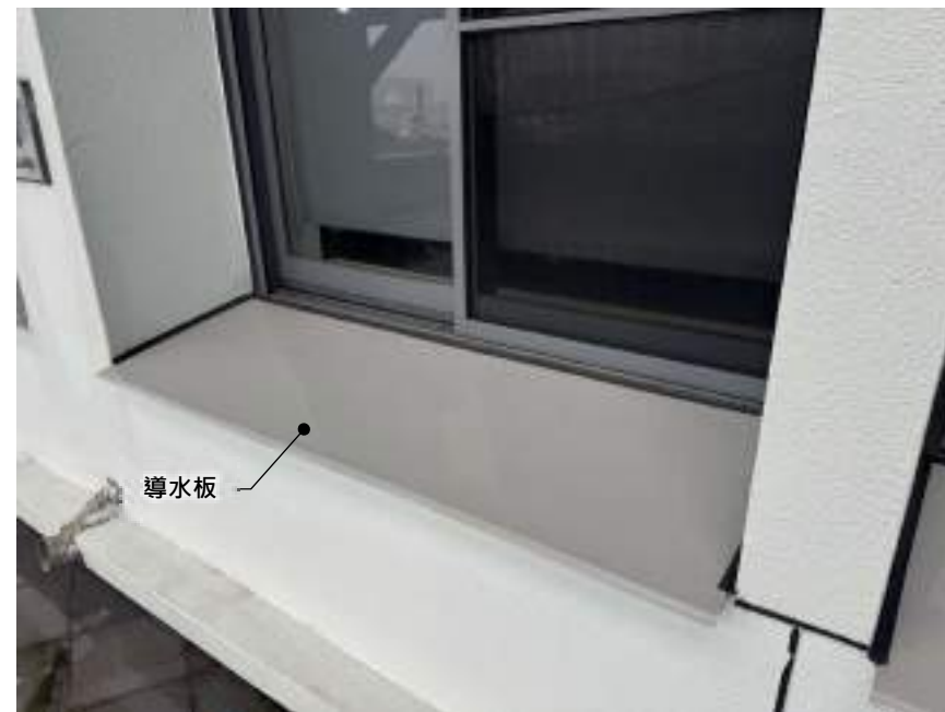
圖G-01-6 導水板示意圖
