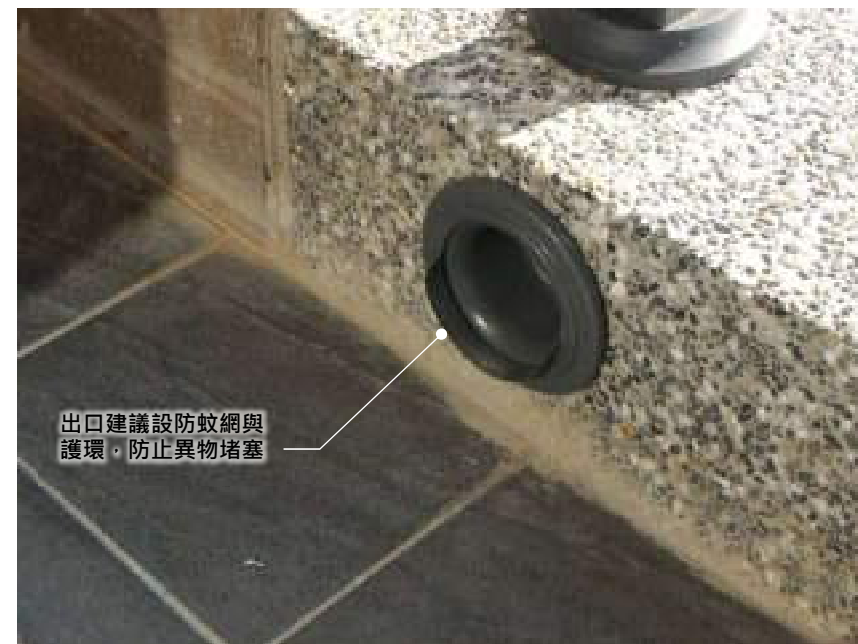
圖G-03-3 溢水口示意圖
