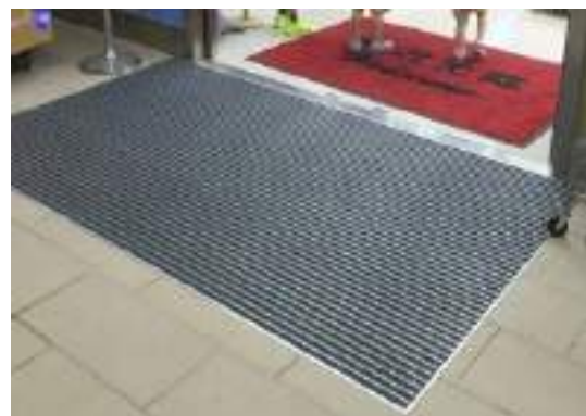
墊面與地面齊平，便於清潔及避免絆倒，邊緣使用金屬框架固定
