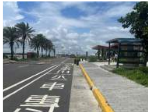
於路面標示供車輛停靠區域
