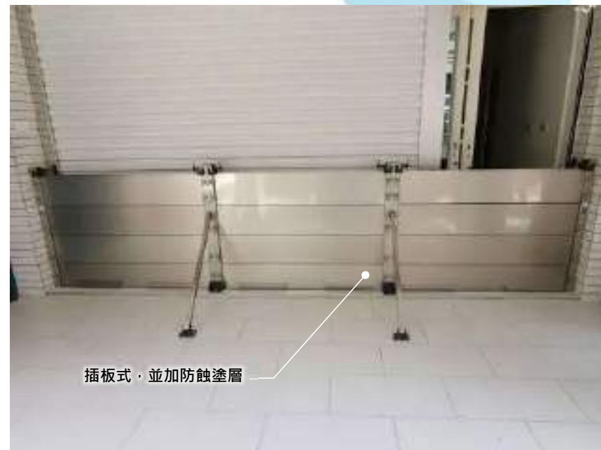
圖F-02-3 插板式防洪閘門示意圖
