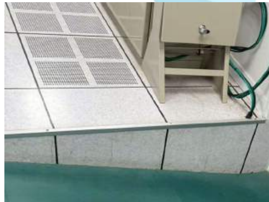
圖F-03-6 高架地板示意圖
