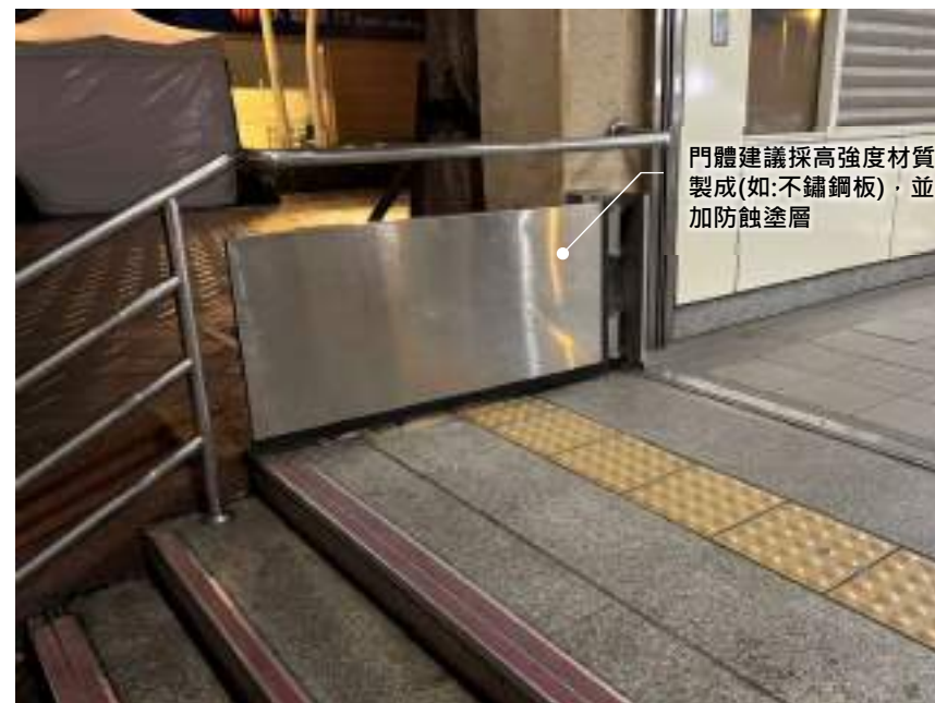
圖F-02-4 扇開式防洪閘門示意圖
