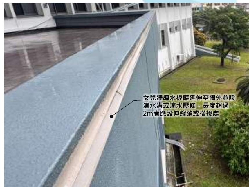
圖G-01-5 導水、滴水板(條)示意圖
