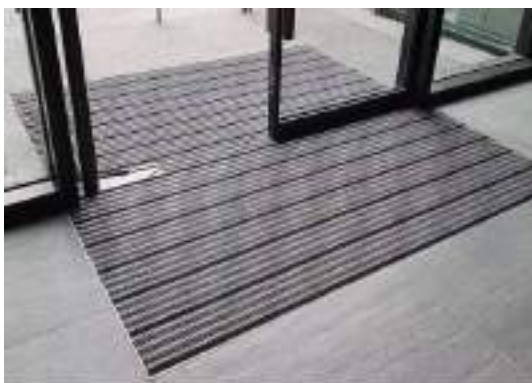
墊面與地面齊平，便於清潔及避免絆倒，邊緣使用金屬框架固定
