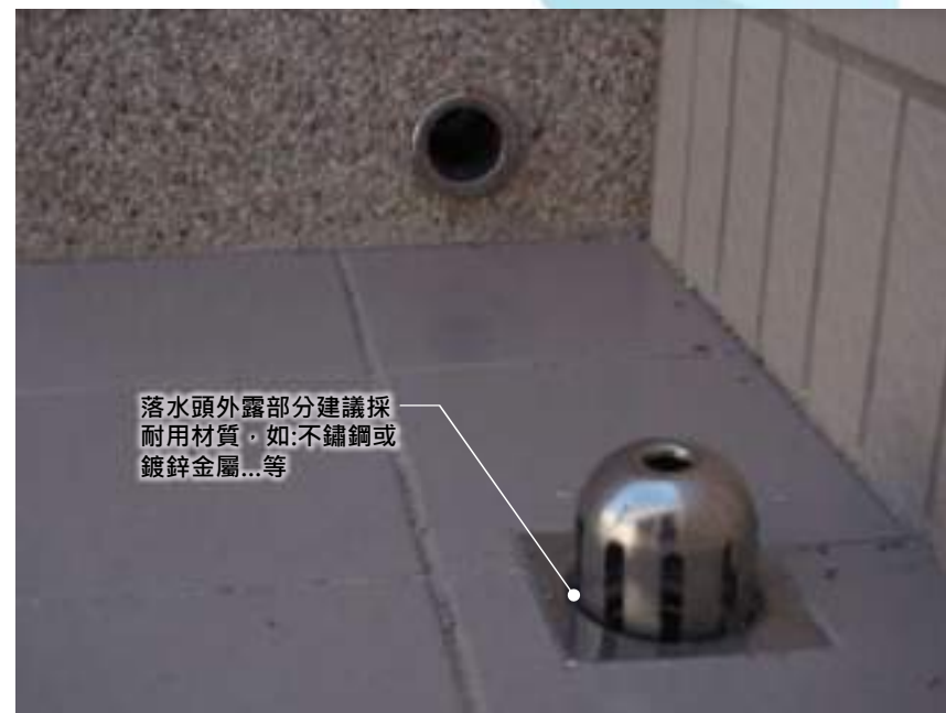
圖G-03-2 落水頭示意圖
