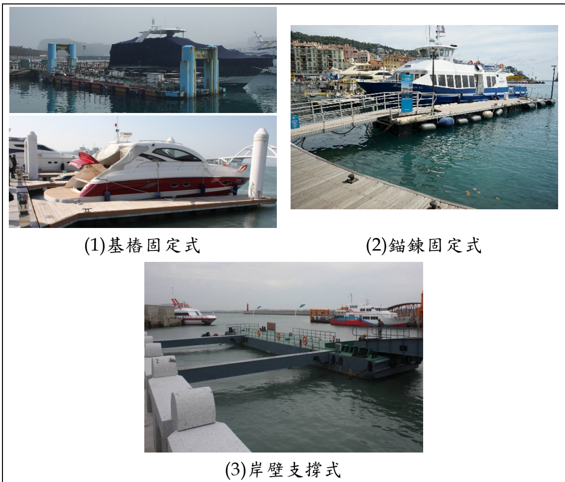
附圖 5.3-2 浮動碼頭固定方式示例
